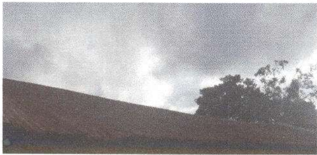
Foto1: Sstitucion de techo por lamina troquelada
