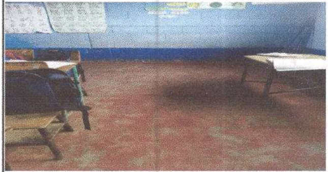
Foto 2: Sustitucion de piso cerámico
