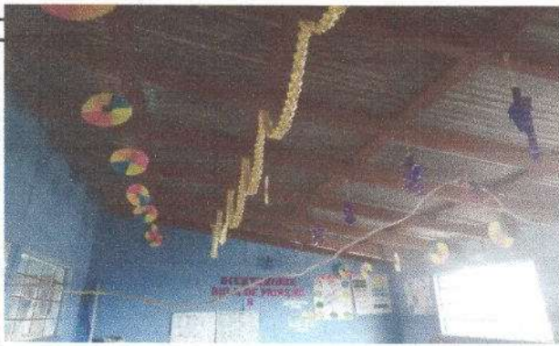
Foto 3: Sustitucion de cableado electrico y accesorios
