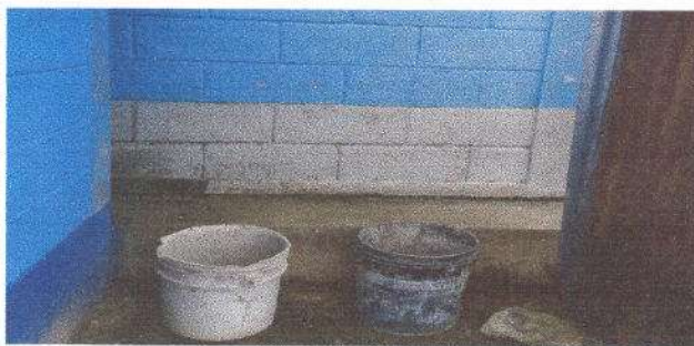
Foto 5: Sustitucion de mingitorios
