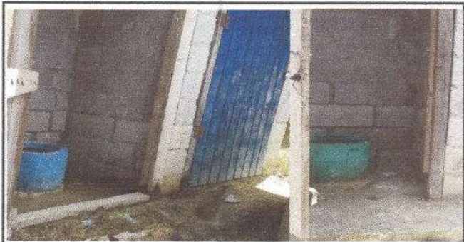
Foto 6: Sustitucion de 3 inodoros
